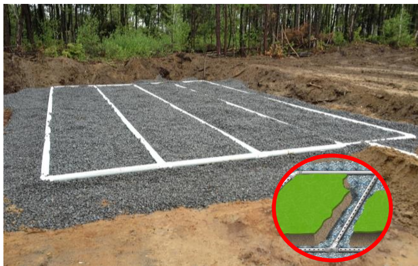
Fig. 3. Photo d'un élément épurateur modifié avant remblayage
